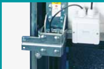
Pojistka přetržení lana
